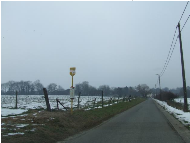
Photo 5. Accès à l'arrêt TEC impraticable, Malèves-Sainte-Marie
