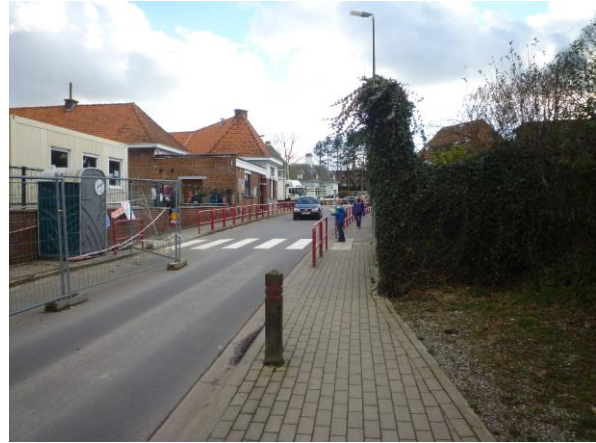
Photo 13. Trottoirs sécurisés rue du Culot
