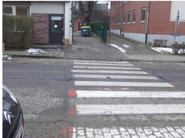
Photo 6. Traversée piétonne inaccessible aux PMR, av. Willmart (N243)
