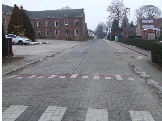
Photo 9. Traversée piétonne sur plateau, au droit de l'école communale « Croque la Vie », à Orbais
