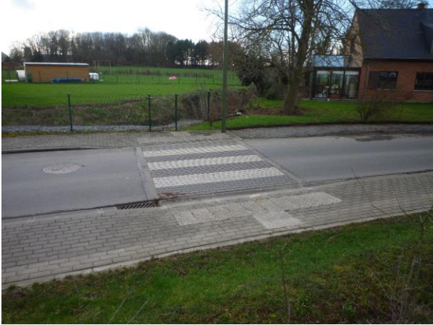
Photo 1. Traversée piétonne avec dalles d'avertissement et bandes de guidage, rue du Culot
