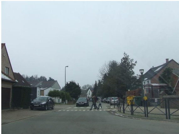
Photo 10. Barrières de protection et traversée piétonne sur plateau, au droit de l'école communale « Les P'tits Futés », à Thorembais-Les-Béguines
