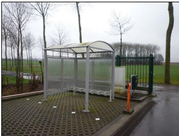
Photo 16. Parking vélo parking de covoiturage (photo prise le jeudi 9 Mars 2017)
