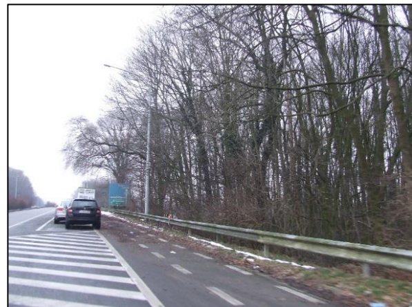
Photo 17. Parkings longitudinal N29 au niveau du pont sur l'autoroute
