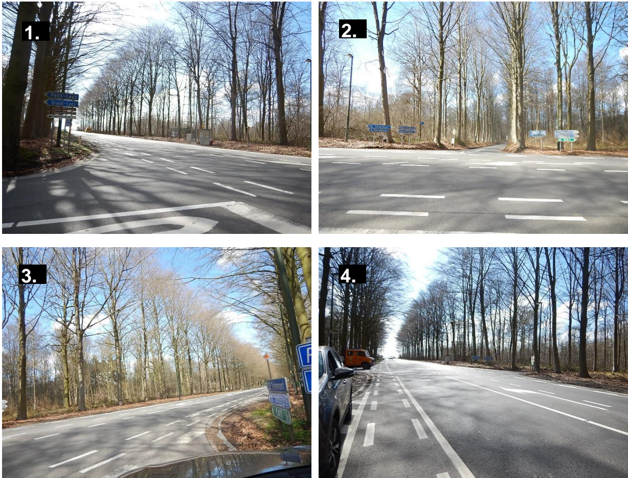
2 Aménagement existant du carrefour chaussée de Charleroi - rue du Bois de Buis
