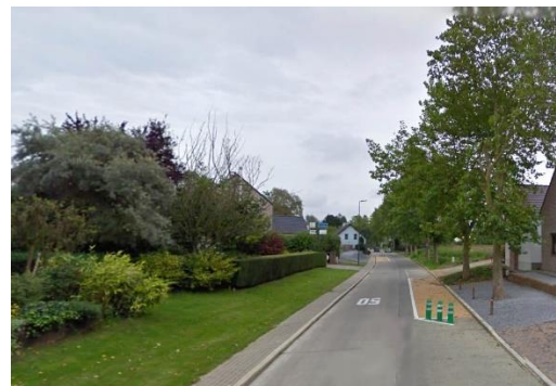
Exemple de mise en œuvre à Glimes (Incourt)
