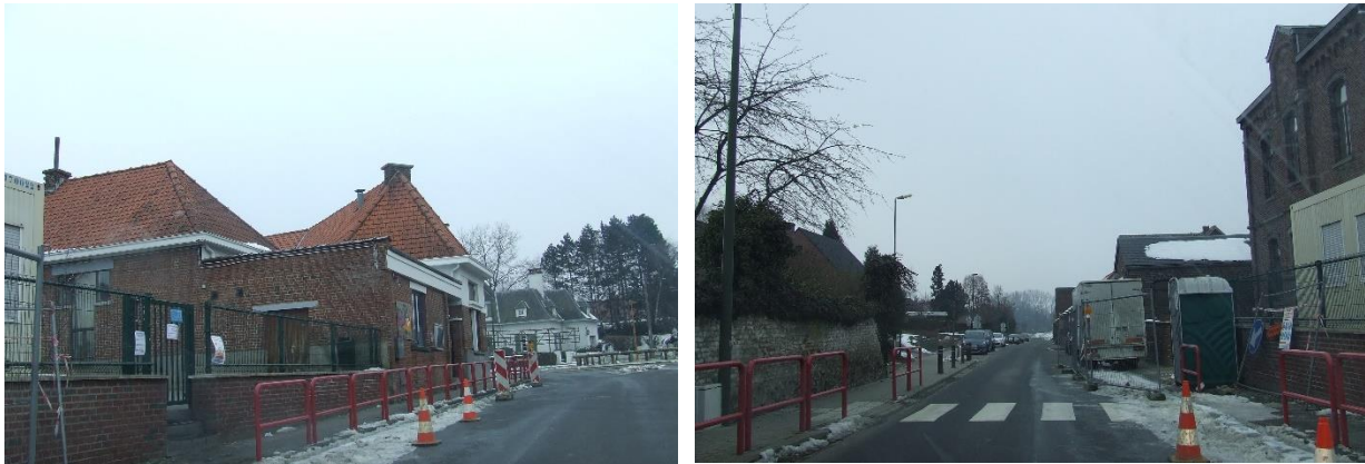
8 Aménagements existants de l'espace public aux abords de l'école de Thorembais-Saint-Trond
