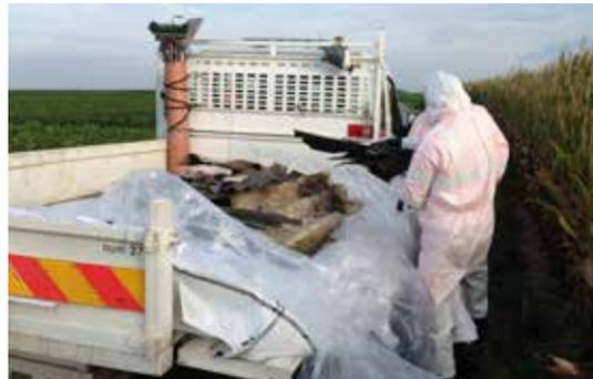
Ramassage d'un dépôt de plaques amiantées.
