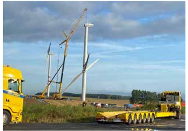
Mises en service entre 2005 et 2006, les 8 éoliennes situées près de l'autoroute sont peu à peu démontées pour être remplacées par 7 nouvelles, plus hautes (180 m) et plus puissantes. La production électrique devrait ainsi passer d'environ 15 000 MWh par an à plus de 70 000. A noter que l'une d'entre elles sera exploitée par la coopérative HesbEnergie en partenariat avec la Commune, une éolienne citoyenne.
